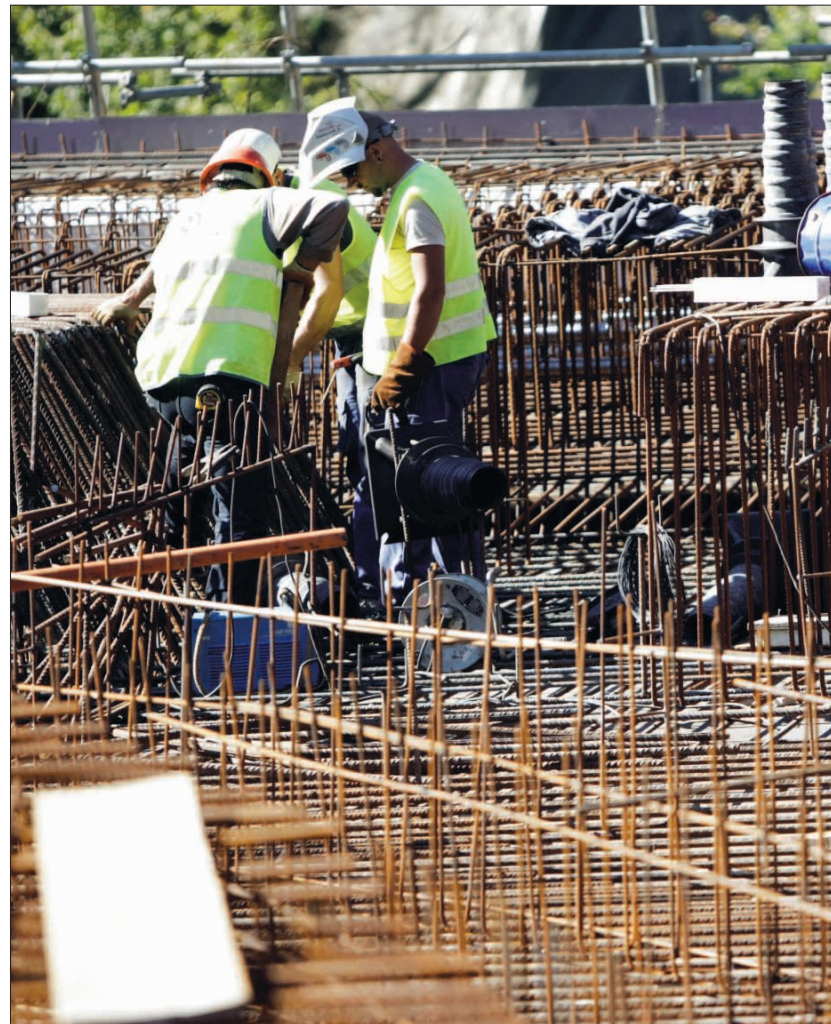
►► Uns treballadors controlen els encofrats en una gran infraestructura.
