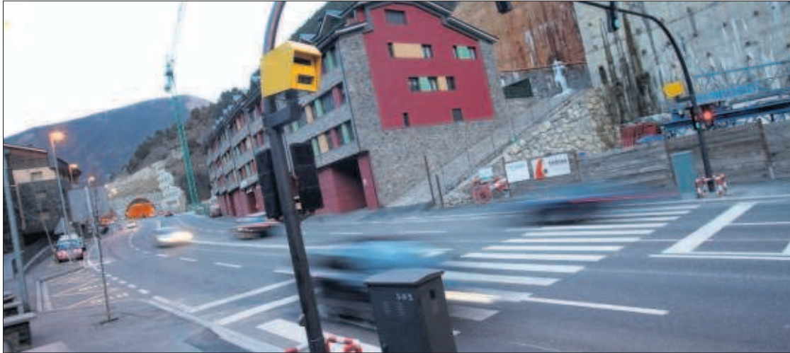
La carretera General 2 al seu pas per la urbanització Valira Nova.
