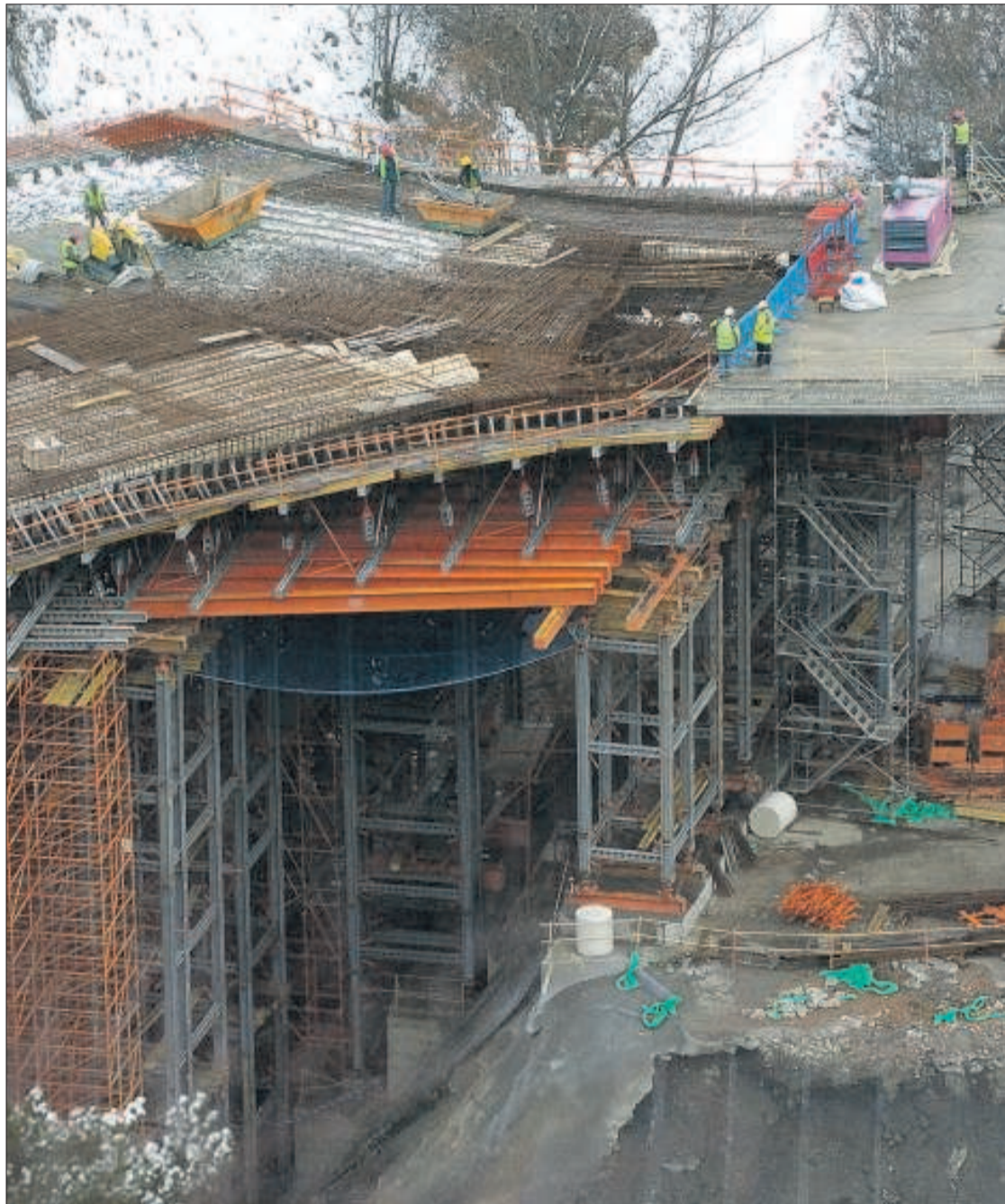
Els obrers del túnel dels Dos Valires treballaven ahir prop de la zona del sinistre mortal.
