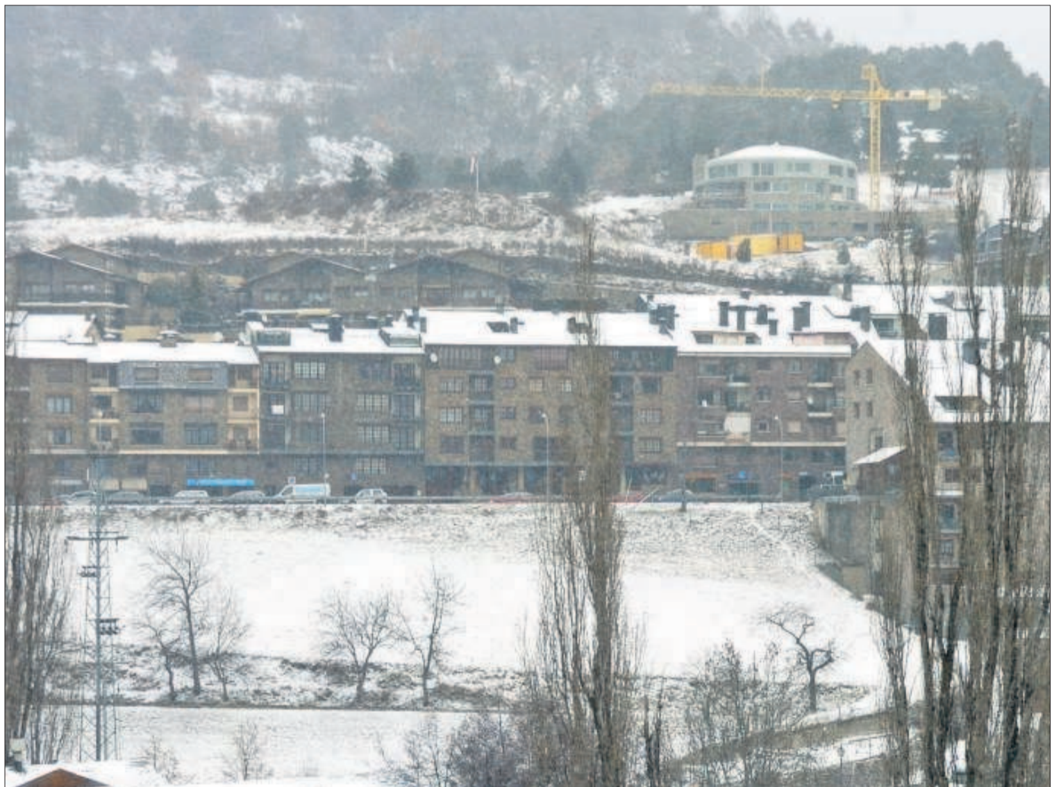
La parcel·la on sembla que finalment es construirà l'equipament, entre el camí de les Palanques i la carretera general d'Ordino.
