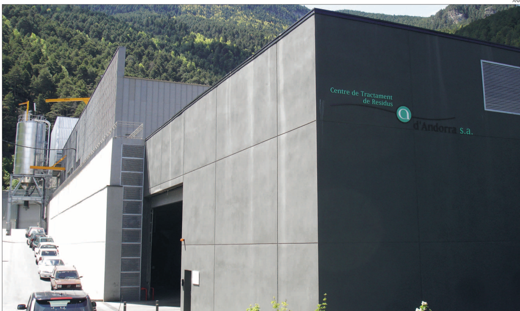
► La façana del Centre de Tractament de Residus
