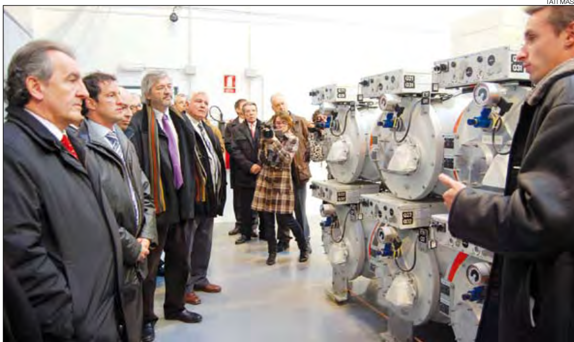
Jaume Bartumeu, Pere López i Vicenç Alay visiten, ahir, l'interior de l'estació transformadora i repartidora de Grau Roig.
