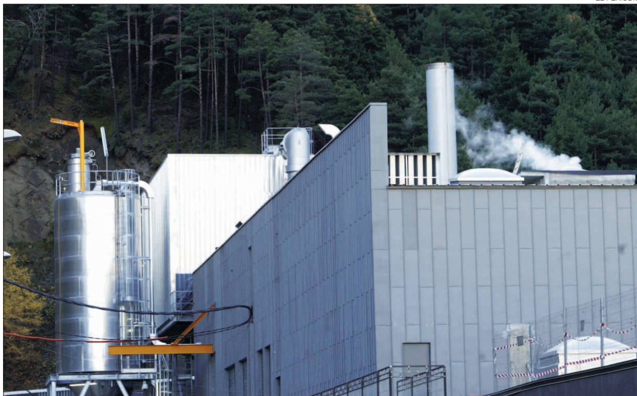
► Vista exterior de la zona del forn incinerador del CTR.
