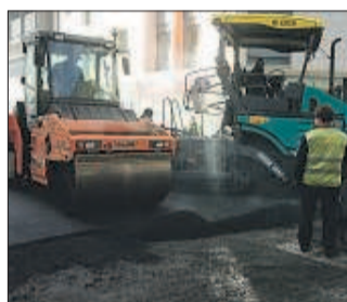
Pavimentació de carrers.
