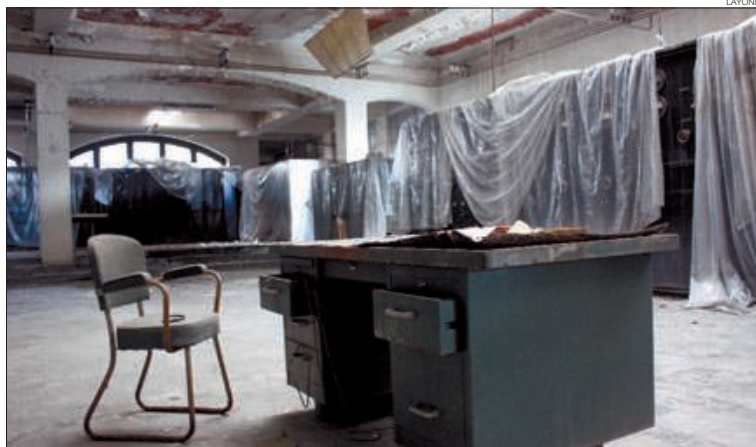
► Vista de la sala de màquines de l'històric edifici encampada, amb les emissores protegides per plàstics.
