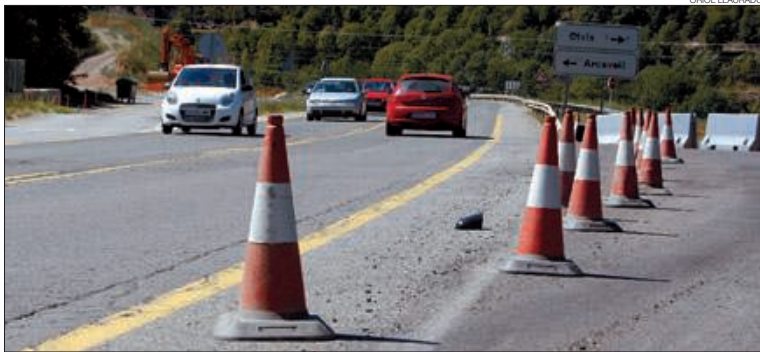
▶▶ Un dels trams en obres a la carretera N-145, que uneix la Seu d'Urgell amb Andorra.
