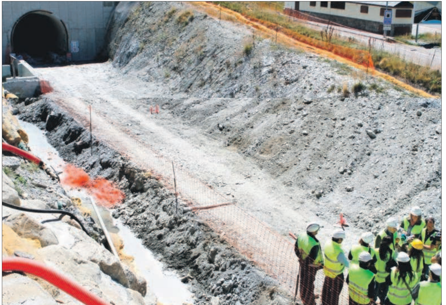
El ministre atén als mitjans de comunicació al costat de la boca de la galeria d'excavació.
