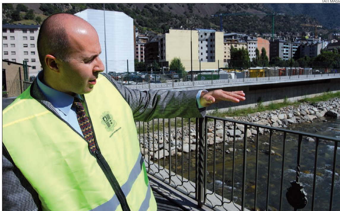
Barcia durant la visita a les obres de canalització de la Valira entre els ponts de Prada Casadet i Tobira, ahir.
