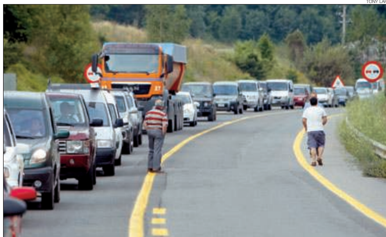
► Un dels trams de la N-145 que estan en obres, afectat per la gran densitat de circulació.
