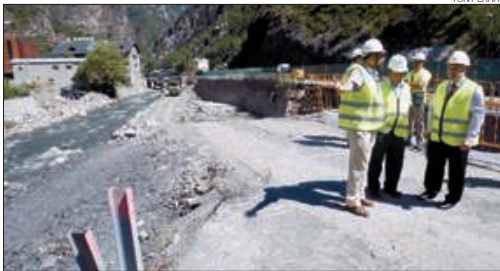
► El ministre Gerard Barcia visita les obres del vial de Sant Julià, ahir.
