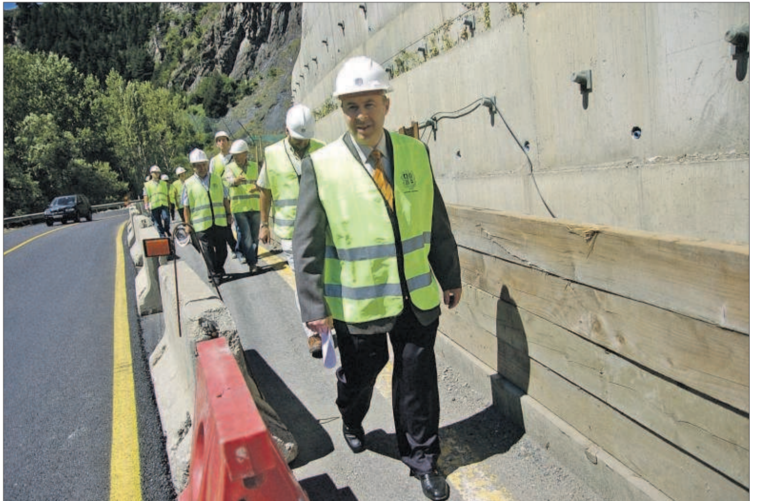
Barcia i els responsables del ministeri, en la visita que van fer al matí a l'obra d'entrada a Canillo, a l'altura del Roc del Quer.
