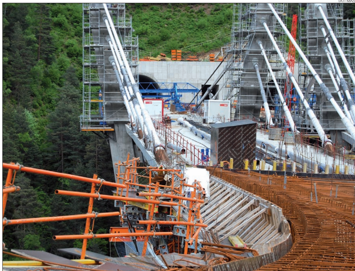
La constructora podrà començar a partir d'avui l'aixecament de la nova línia de torres de sosteniment de l'estructura.
