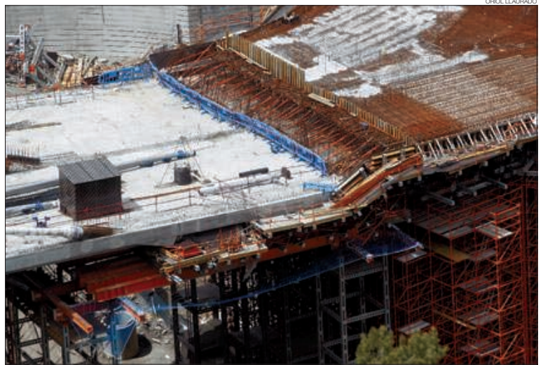
▶ Vista del desnivell accidentat del vial de sortida de la boca oest del túnel dels Dos Valires.
