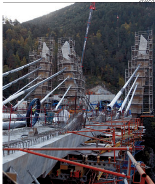
► La boca oest del túnel dels Dos Valires.
