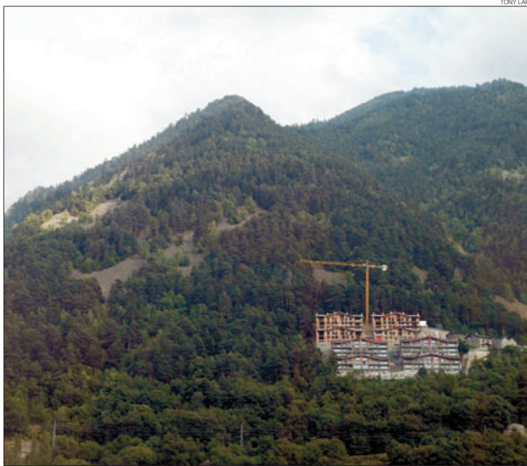
► Construcció d'un edifici a la Comella.
