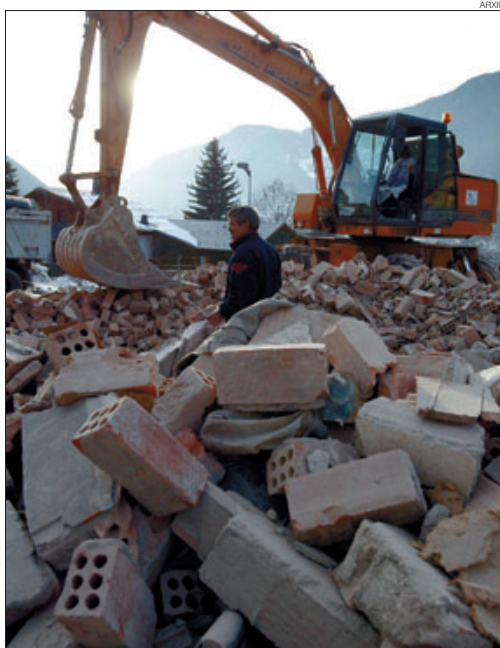
►► Les obres de desmuntatge d'un edifici de la capital.
