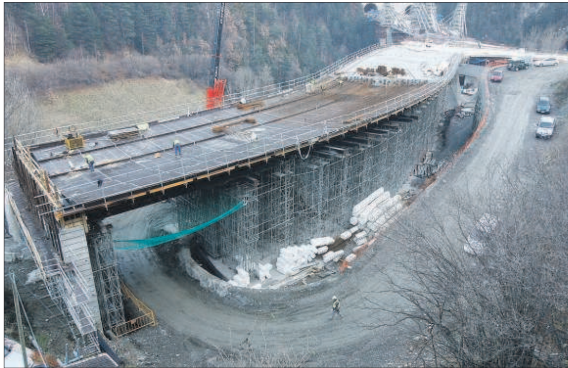
Ahir es van reprendre les obres per reforçar la part de l'estructura ja executada.
