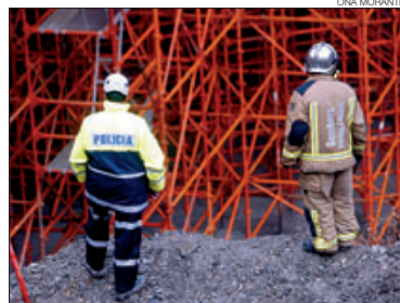
► Dos agents observen l'encofrat.
