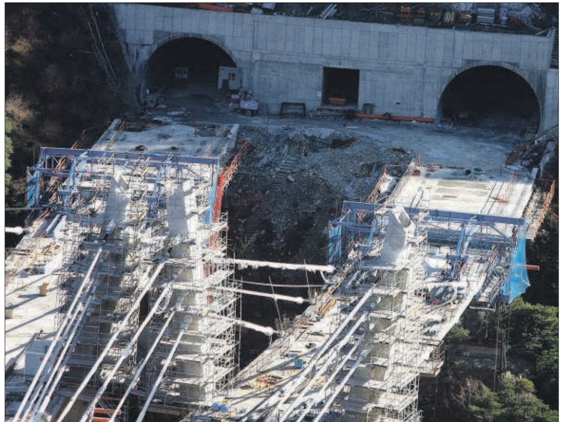
Imatge del pont en construcció a la sortida del túnel.
