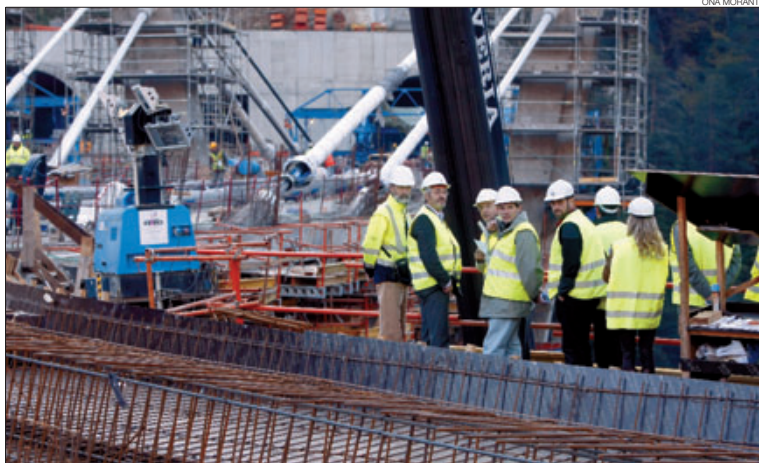
► Alay, acompanyat de tècnics i treballadors, durant la visita a les obres de la boca oest del túnel, ahir.
