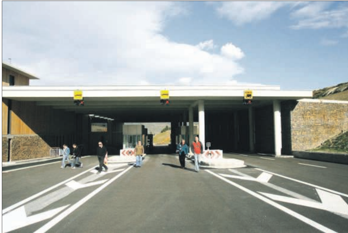
Les instal·lacions de la nova duana juxtaposada.
