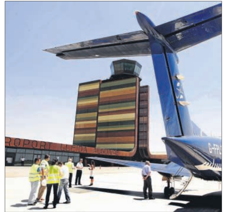
L'aeroport d'Alguaire està en l'última fase de les obres.
