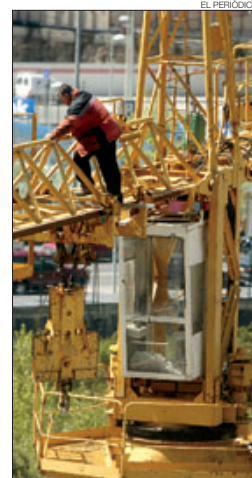
► Un obrer de la construcció.
